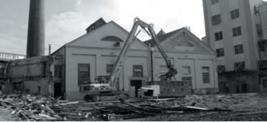
Abrissarbeiten auf dem Nestlé-Gelände in Ludwigsburg
