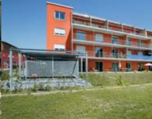
Geschosswohnungsbau in Smiley West
