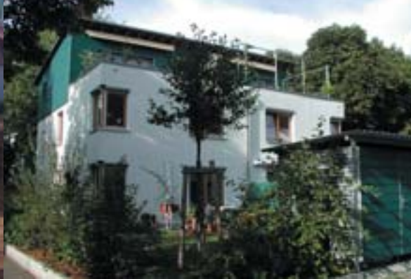
Hier entstehen Doppel- und Reihenhäuser
