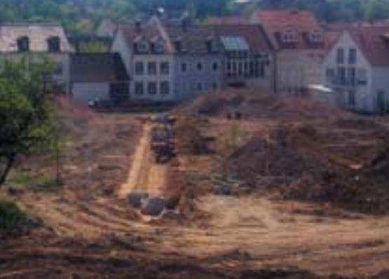
Neues Baugebiet im Zentrum von Bruchsal
